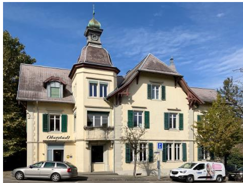
Abbildung 23 Restaurant Oberstadt (Quelle: Stadt Baden, Denkmalwerkstatt, 2023)
