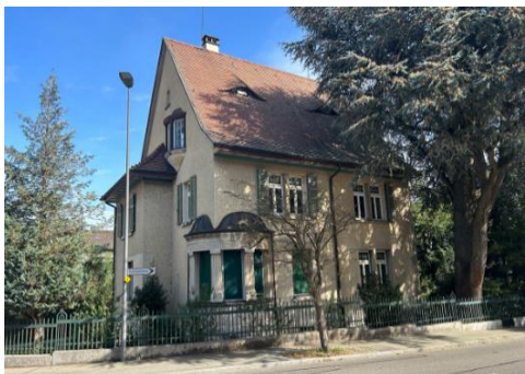
Abbildung 24 Oberstadtstrasse 9 (Quelle: Denkmalwerkstatt, 2023)
